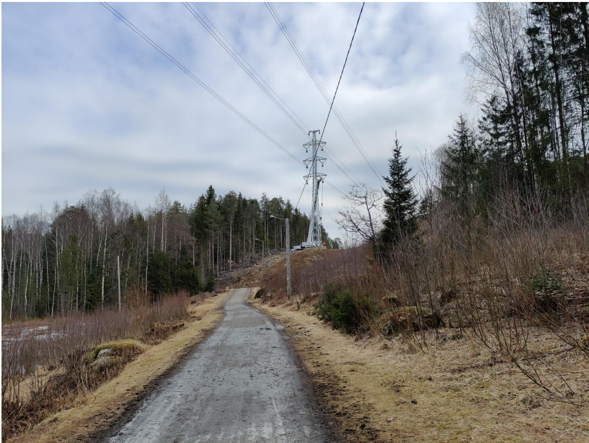
Kuva 5-4. Hankealueen pohjoispuolelle sijoittuva voimalinja kuvattuna itään.
